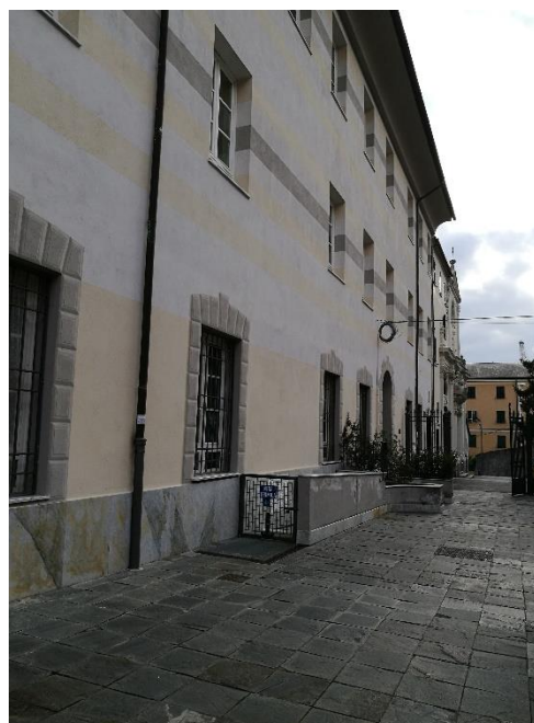
Figura 8.1 - Particolare muratura esterna
