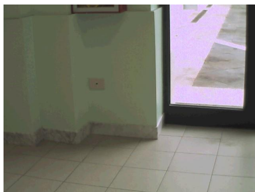
Figura 4.4 – Rilievo termografico serramenti sala mensa
