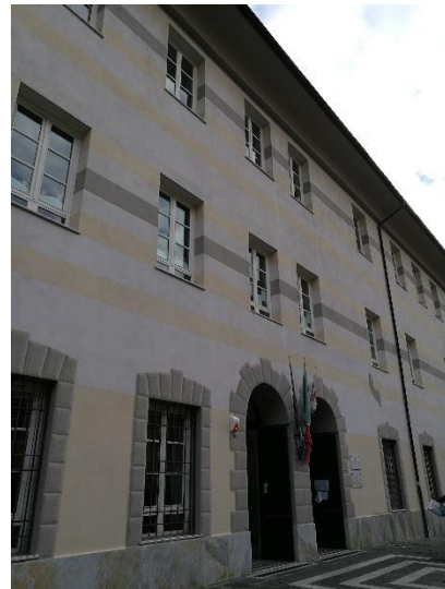
Figura 4.1 - Particolare facciata Nord-Ovest fabbricato
