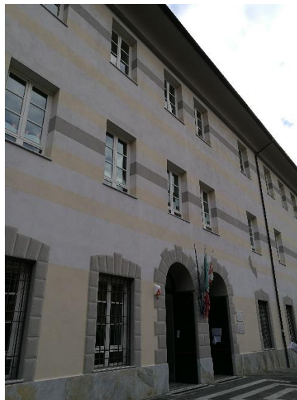
Figura 1.1 - Vista della facciata Nord-Ovest
